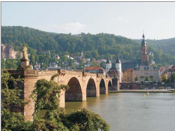
Alte Brücke von der nördlichen Neckarseite
