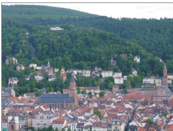
Kernaltstadt und Schlossberg berg mit insgesamt 150 Wohneinheiten, an denen zum Teil Sanierungsbedarf besteht.
