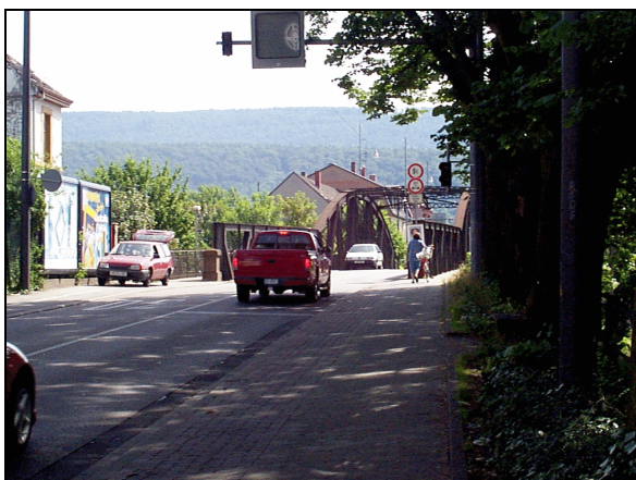
Bürgerstraße und Bürgerbrücke in Richtung Rohrbach
