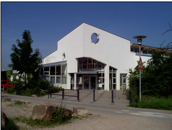
Kindergarten „Im Hüttenbühl“
