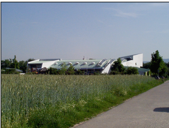
Kindergarten mit angrenzender Wohnbaufläche entlang der Straße „Im Hüttenbühl“
