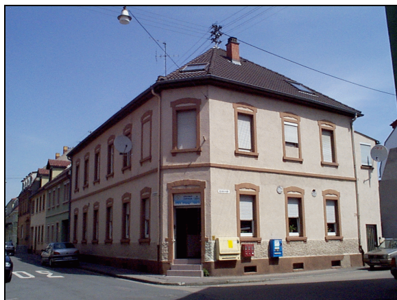
Seniorenzentrum in der Alstater Straße
