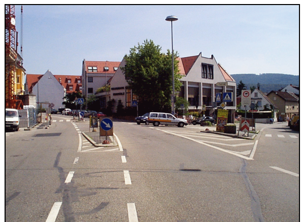
Überdimensionierter Kreuzungsbereich Schwetzingen Straße / Odenwaldstraße
