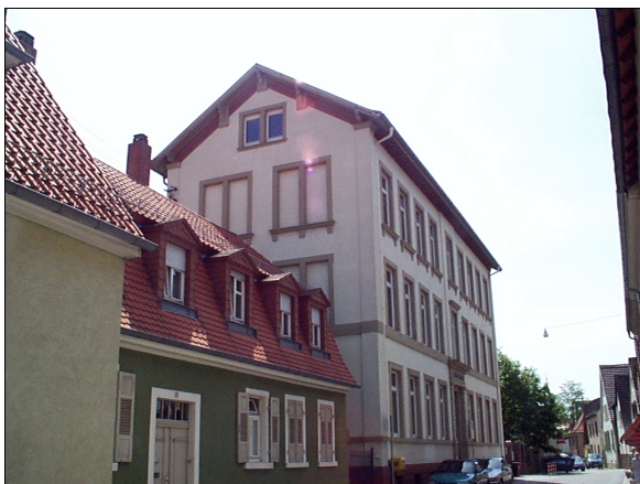
Kurpfalzschule: Aufwertung der Außenanlage
